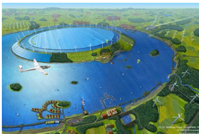
Abb. 13. Ringwallspeicher-Hybridkraftwerk mit 3,2 GW Spitzen- und 2 GW Durchschnittsleistung bei einer Reichweite von 14 Tagen. (Illustration: Stefan Schiessl, Dachau)
